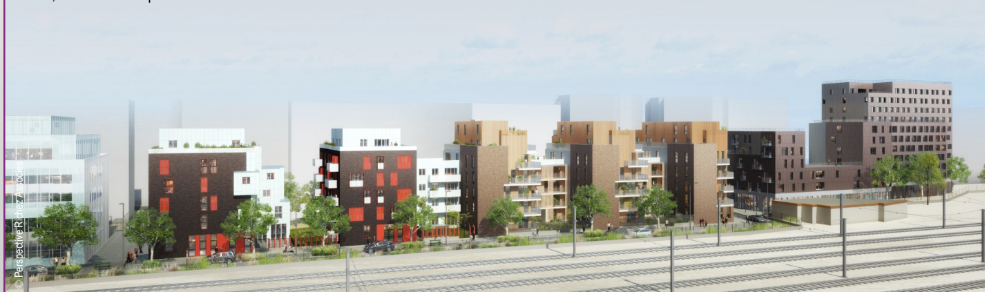
Lots 4, 5 et 6 réalisés par ICF LA SABLIERE et ICF NOVEDIS
